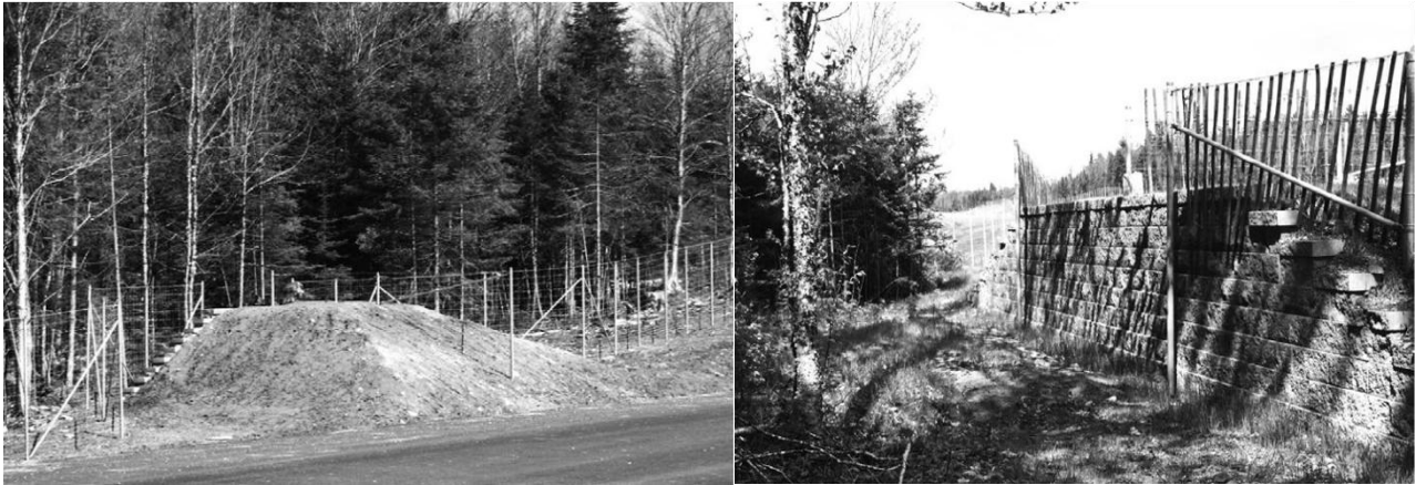
Figure 14. Sautoir construit en Beauce. À gauche : vue de la pente douce du côté de l'autoroute Robert-Cliche (A73) ; à droite : vue du mur du côté de la forêt (Source : Lavoie et al., 2012)
