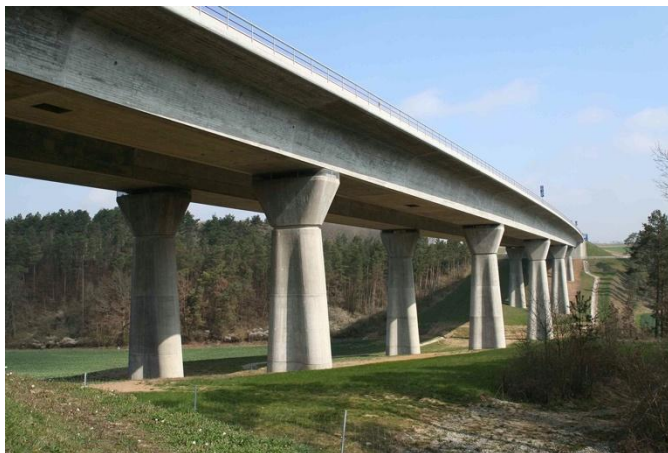
Figure 6. Exemple de viaduc en Allemagne (© Störfix)
