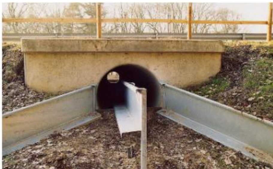
Figure 11. Tunnel pour reptiles et amphibiens dans le nord de l'Allemagne (© Christian Fischer)
