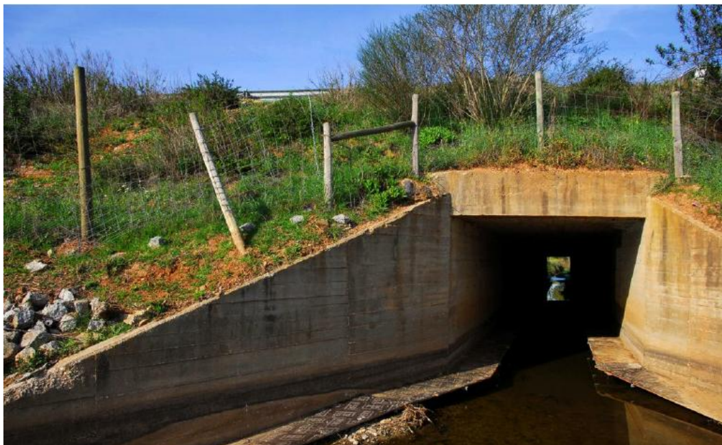
Figure 9. Ponceau modifié avec l'ajout de tablettes en porte-à-faux (© Joaquim Pedro Ferreira)
