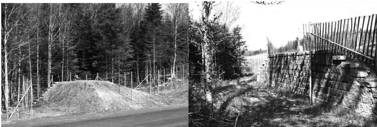
Figure 2.11. Photos d'un sautoir construit en Beauce. À gauche : vue de la pente douce du côté de l'autoroute Robert-Cliche (A73) ; À droite : vue du mur du côté de la forêt (tirées de : Lavoie et al., 2012)
