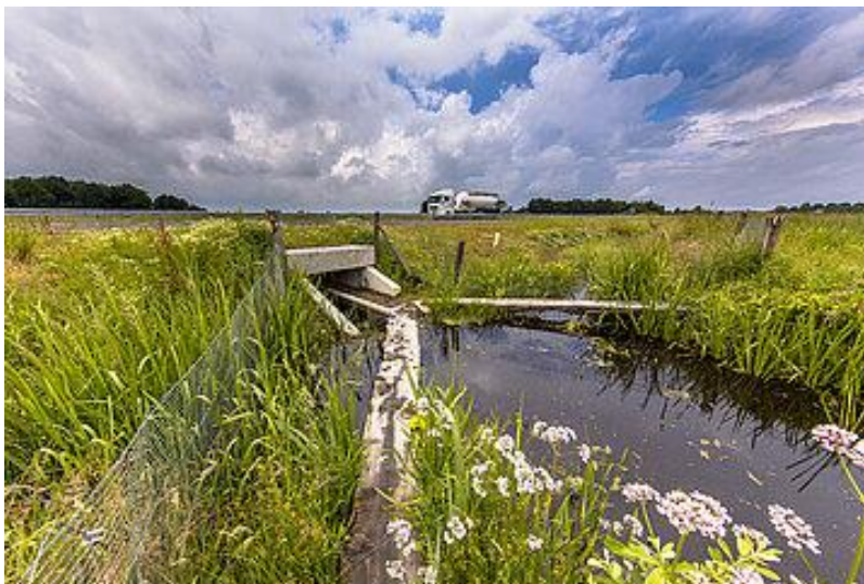
Figure 2.4. Photo d'un ponceau modifié avec l'ajout de tablettes en porte-à-faux (© CreativeNature)
