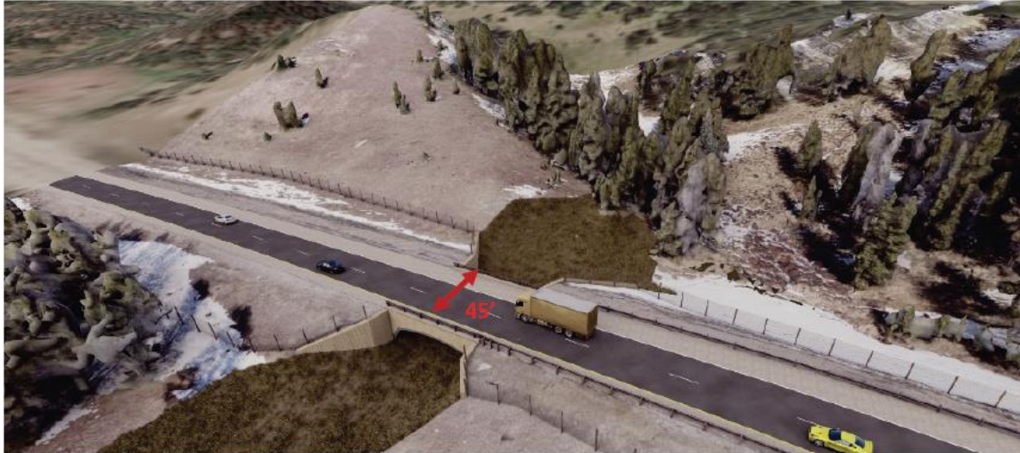
Figure 10 : Passage inférieur – Arche enterrée (© Summit County Safe Passage, 2020)
