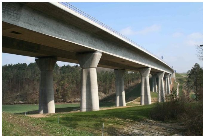
Figure 2.1. Exemple de viaduc en Allemagne (© Störfix)
