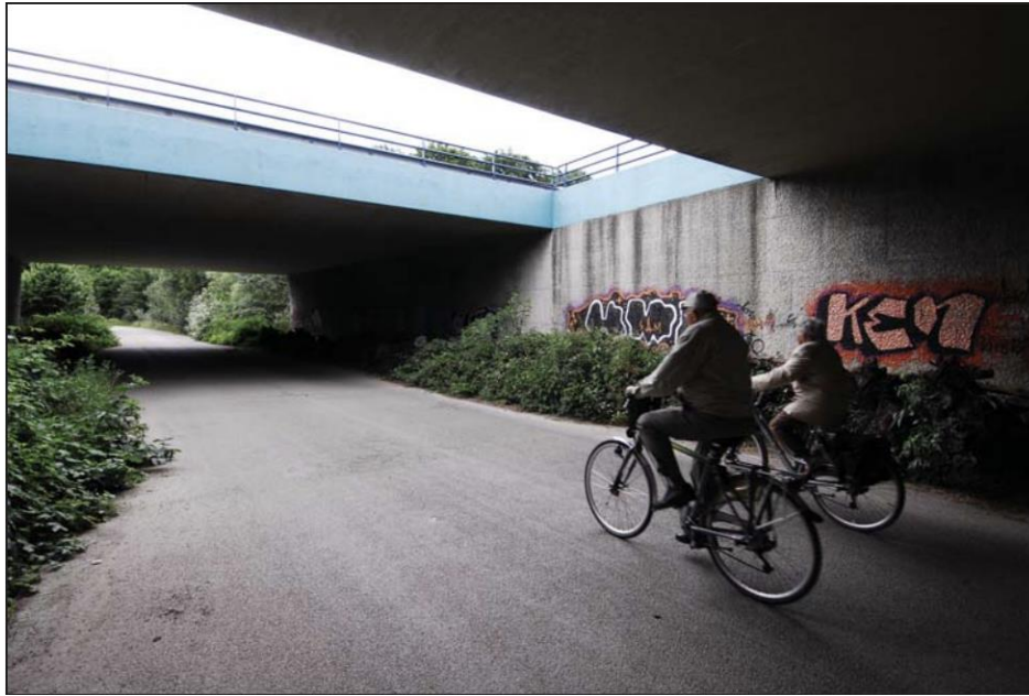
Figure 2.3. Photo d'un passage inférieur mixte avec piste cyclable aux Pays-Bas (© Marcel Huijser)
